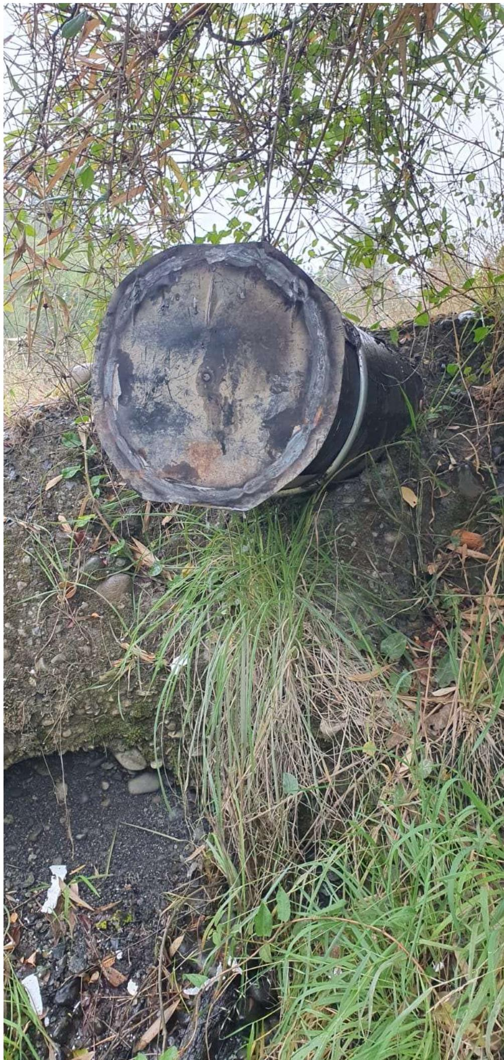
4) Imagen del tubo con tapa metálica lateral para observar la forma de fijación de la tapa
