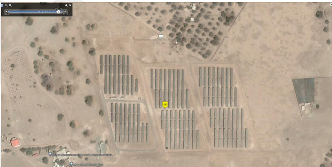
Figura 1: Parque Solar Tamarugo, enero de 2021 – Vista Google Earth
