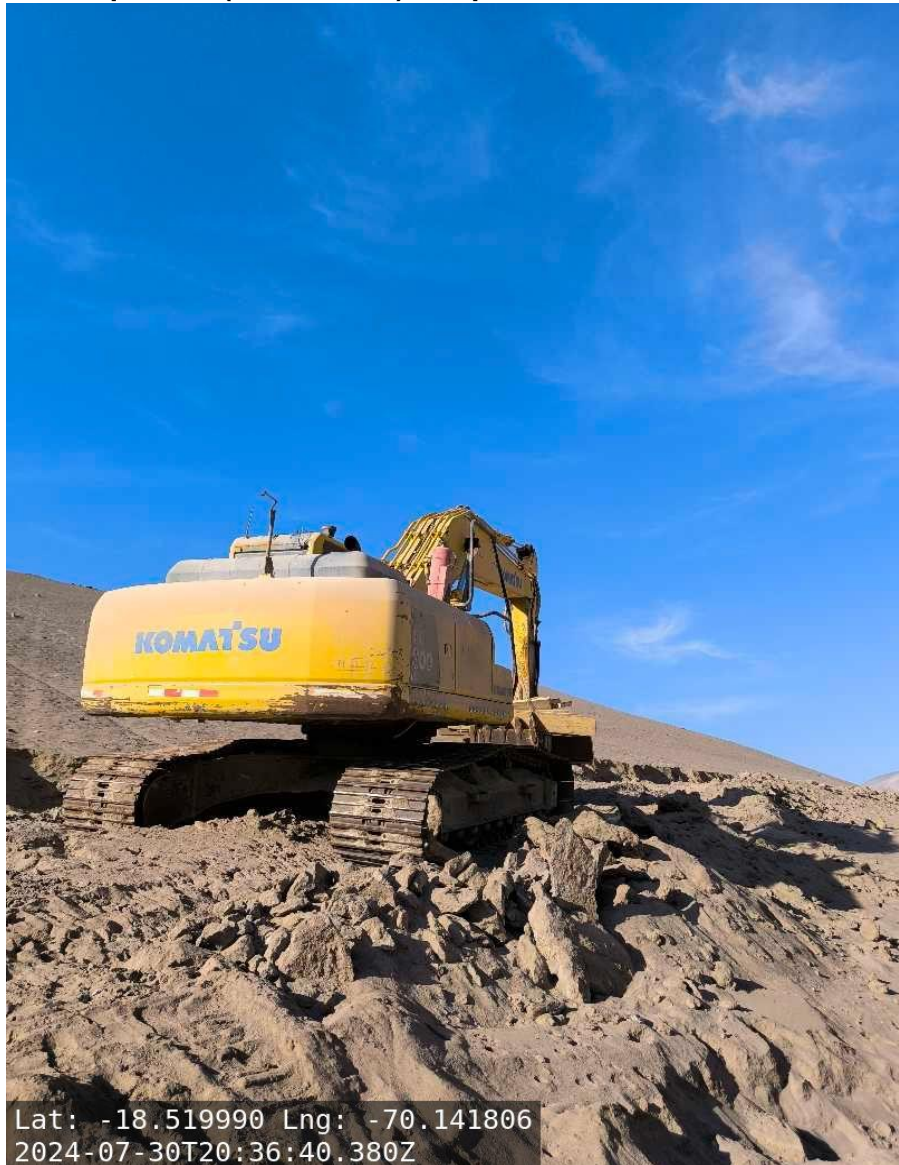
Figura 5: Maquinaria (Excavadora) 02 apostada en la línea de media tensión.
