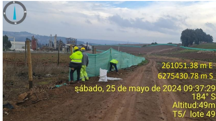
Figura 12: Malla raschel instalada en el sector B.5
