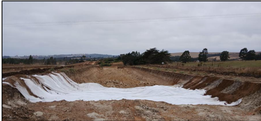
Figura 30: Imagen referencial instalación geotextil
