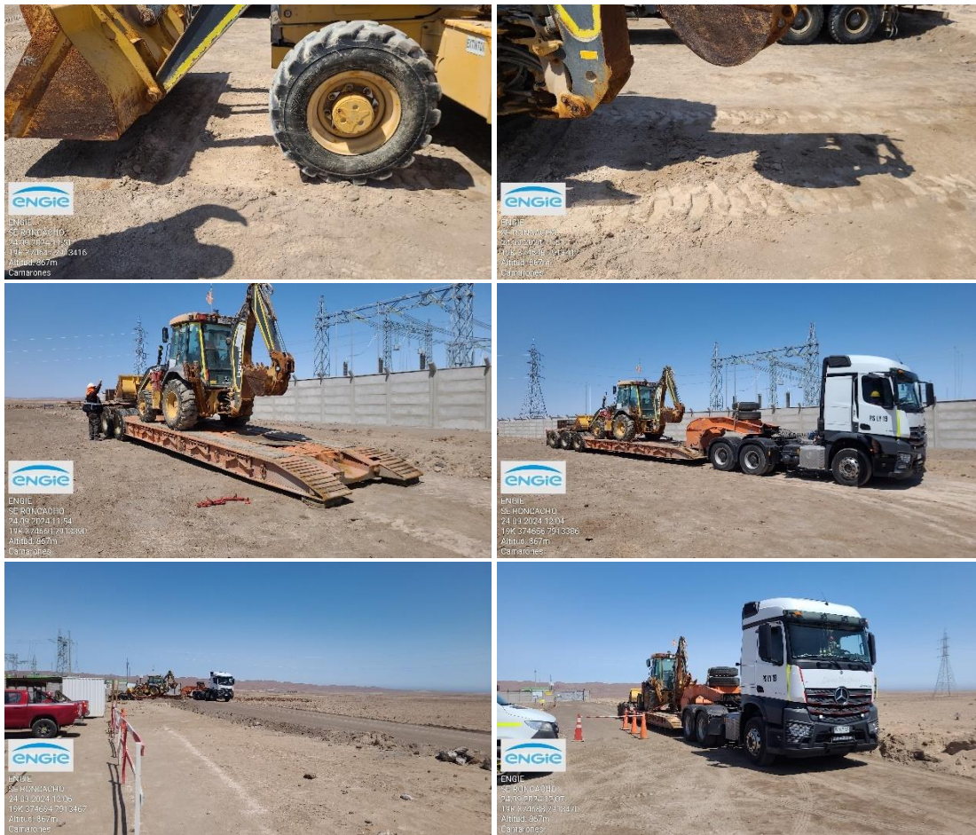
Figura 7. Set de fotografías del retiro de la Retroexcavadora.
