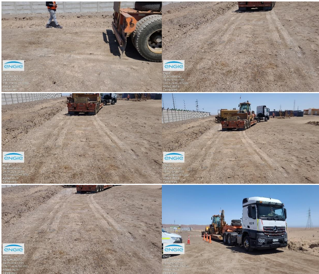
Figura 8. Set de fotografías del retiro de la Cama Baja junto a la Retroexcavadora.
