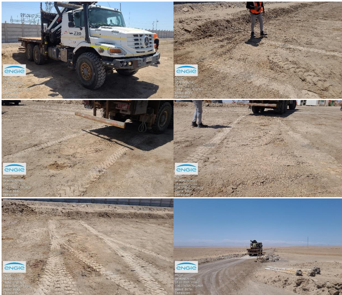
Figura 9. Set de fotografías del retiro del Camión Pluma.
