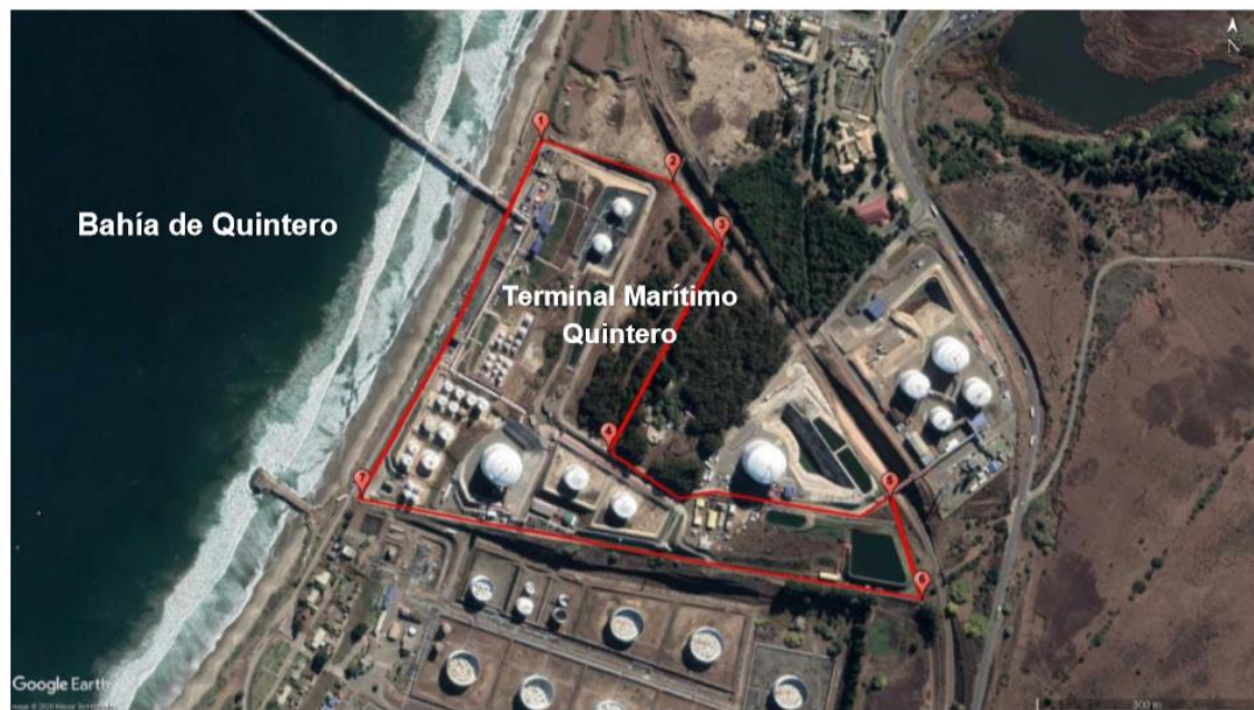
Figura N°1: Vista de la ubicación del Terminal.
