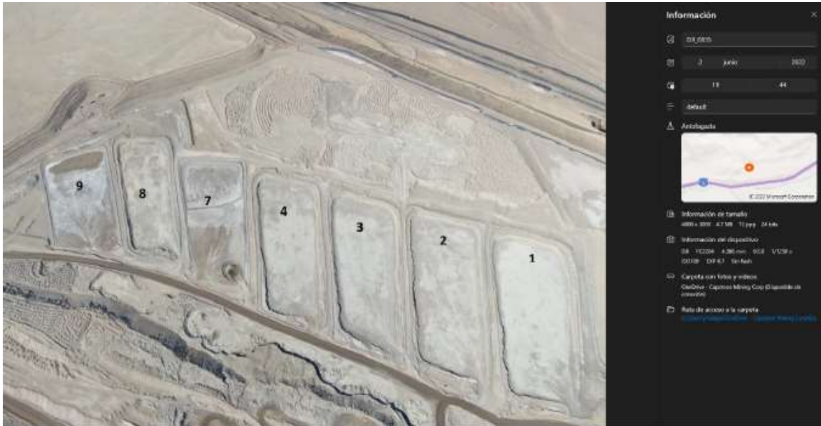
Figura N° 1: Piscinas de emergencia en desuso (22 de junio de 2022)
