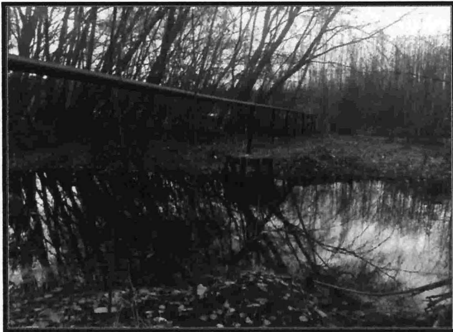
Fig. 1. Ducto de descarga de efluentes al cuerpo receptor Rio Laja.
