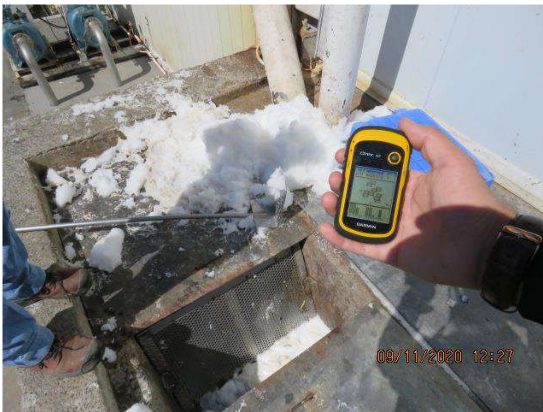
Fig. 1 Salida de ril planta de proceso. Cámara de unión de planta desbizado y proceso
