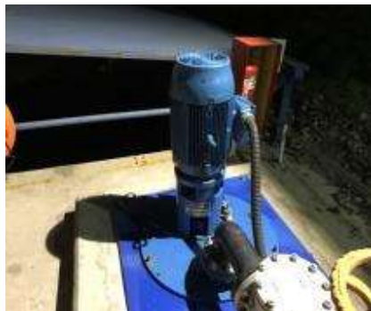
Bomba descarga de riles n° 1 y 2
