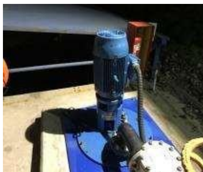
Bomba descarga de riles n° 1 y 2
