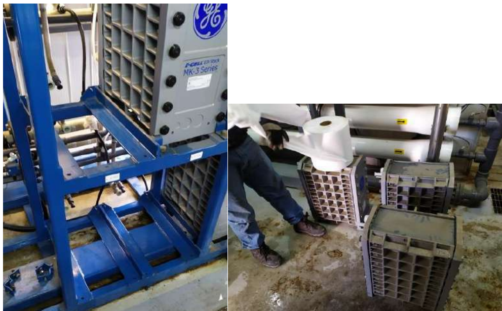
Ilustración 7 Retiro de los Stack
