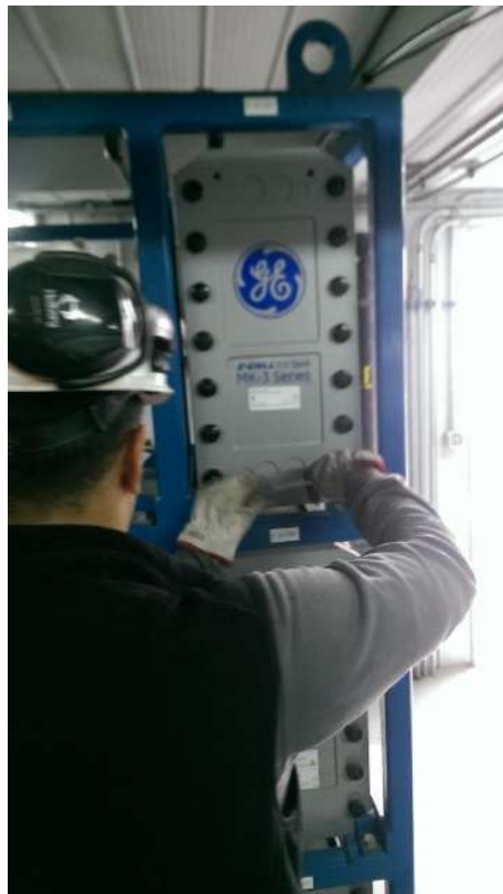
Ilustración 2: Retiro de Stack nuevo
