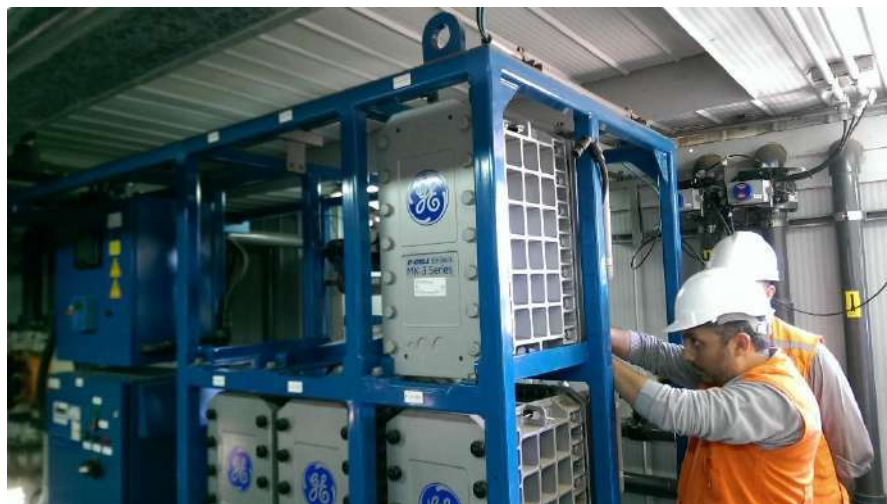
Ilustración 4: Instalación del stack nuevo
