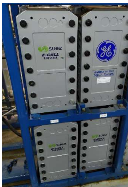
Ilustración 8 Instalación de los nuevos Stack
