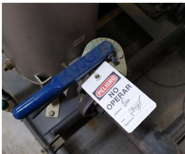
Ilustración 2 Cierre y bloqueo de válvula alimentación del EDI
