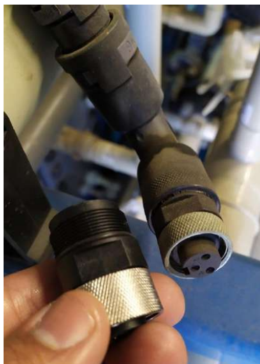
Ilustración 6 Cambio de conexión eléctrica de los Stack
