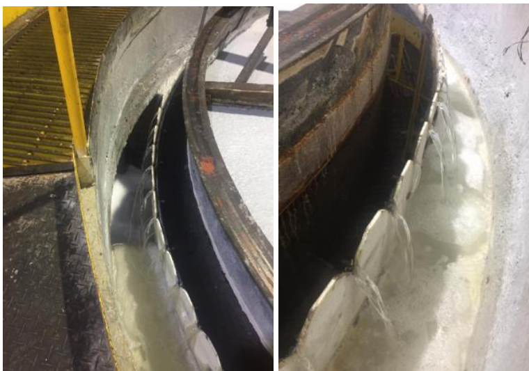
Imagen N°13. Agua clarificada proveniente del flotador
