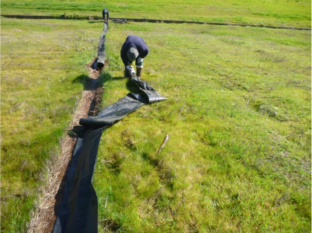
Imagen N° 1.-Instalación de mangas de desagüe de acumulación de agua superficial.
