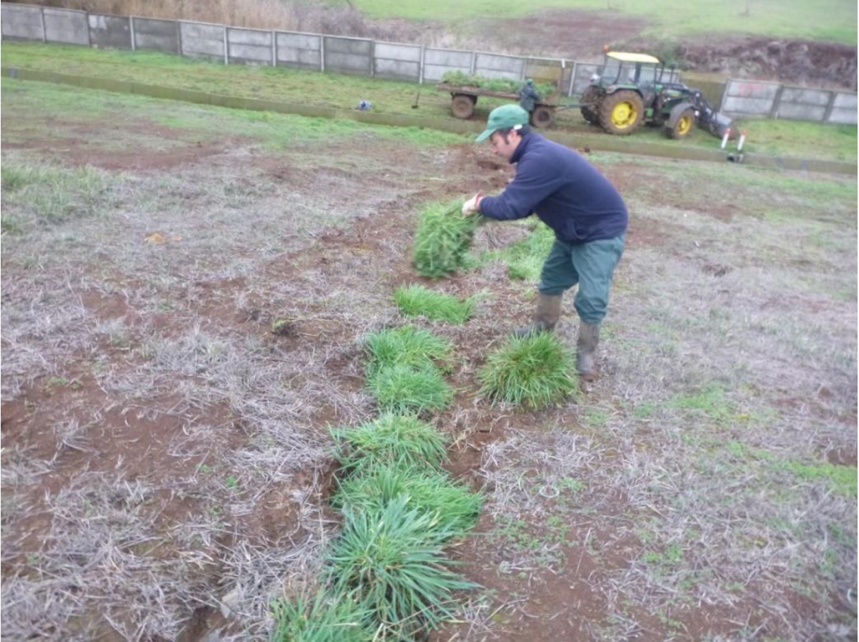
Imagen N° 3.- Reparación cobertura en el cerro por erosión de aguas lluvias en sector C y D, sector Cuzaco.
