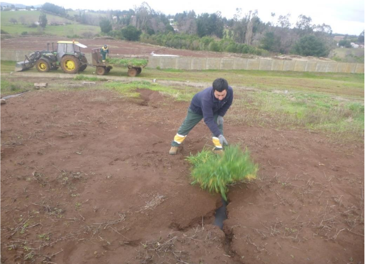
Imagen N° 2.-Reparación y fijación de mangas de evacuación de aguas lluvias del cerro
