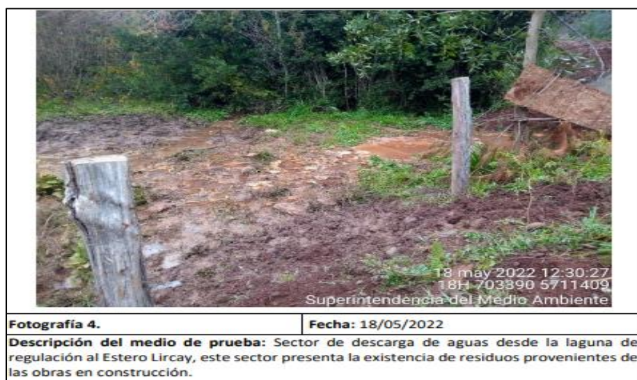
Figura 5: Residuos provenientes de las obras de construcción
