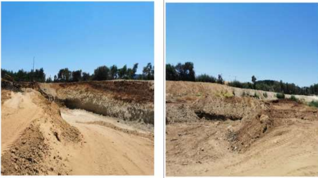
Figura 2: Excavaciones para nuevas celdas
