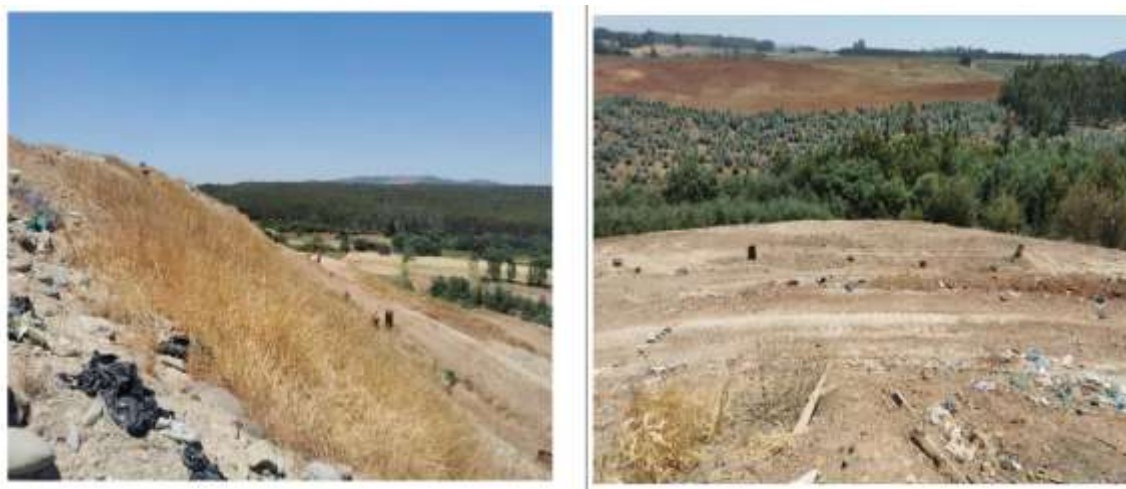
Figura 5: Taludes con cobertura de tierra
