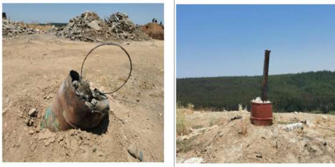
Figura 4: Chimeneas pasivas de extracción de biogás
