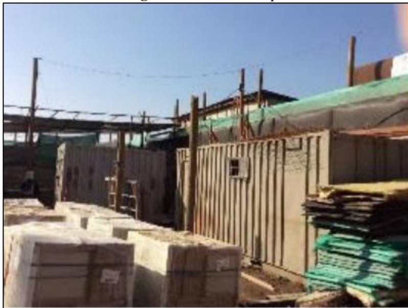
Figura 9: Sector de acopio
