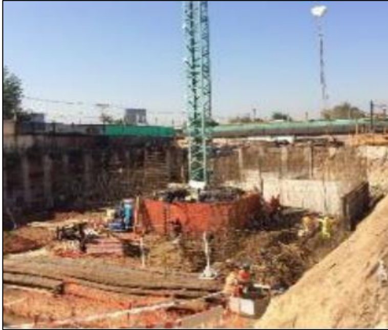
Figura 10: Excavación Condominio Santa María
