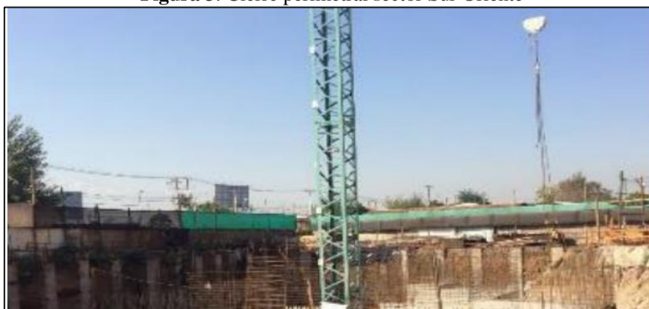
Figura 3: Cierre perimetral sector Sur Oriente
