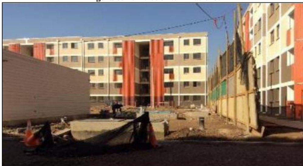
Figura 6: Edificios en terminaciones
