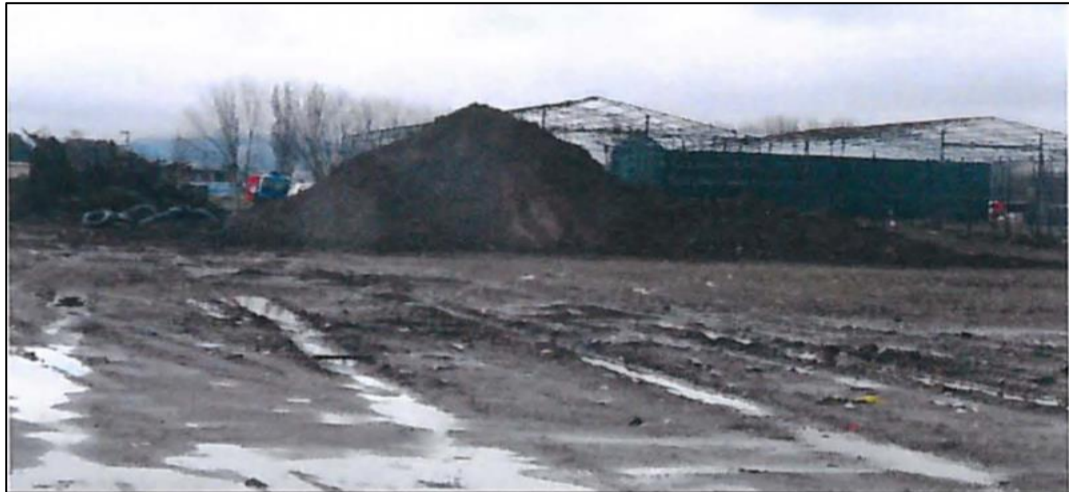
Fuente: Acta de Inspección de 14 de julio de 2022
