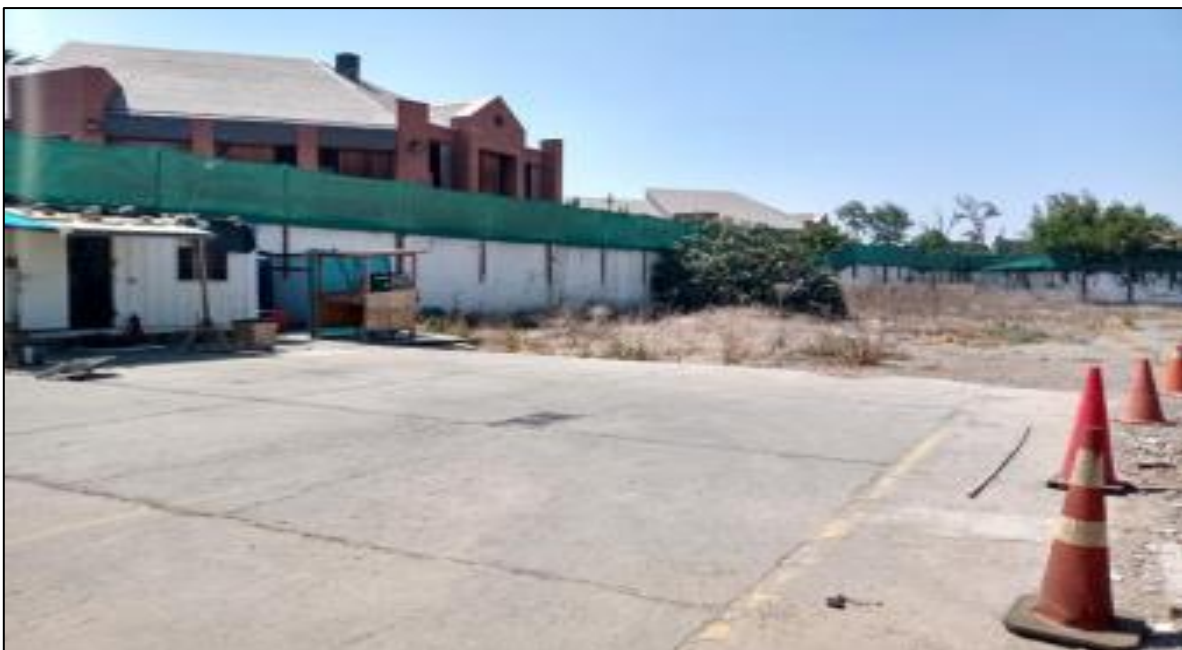
Imagen N° 2: Caseta y radier existentes en el sitio de emplazamiento del proyecto “San Pablo”.
