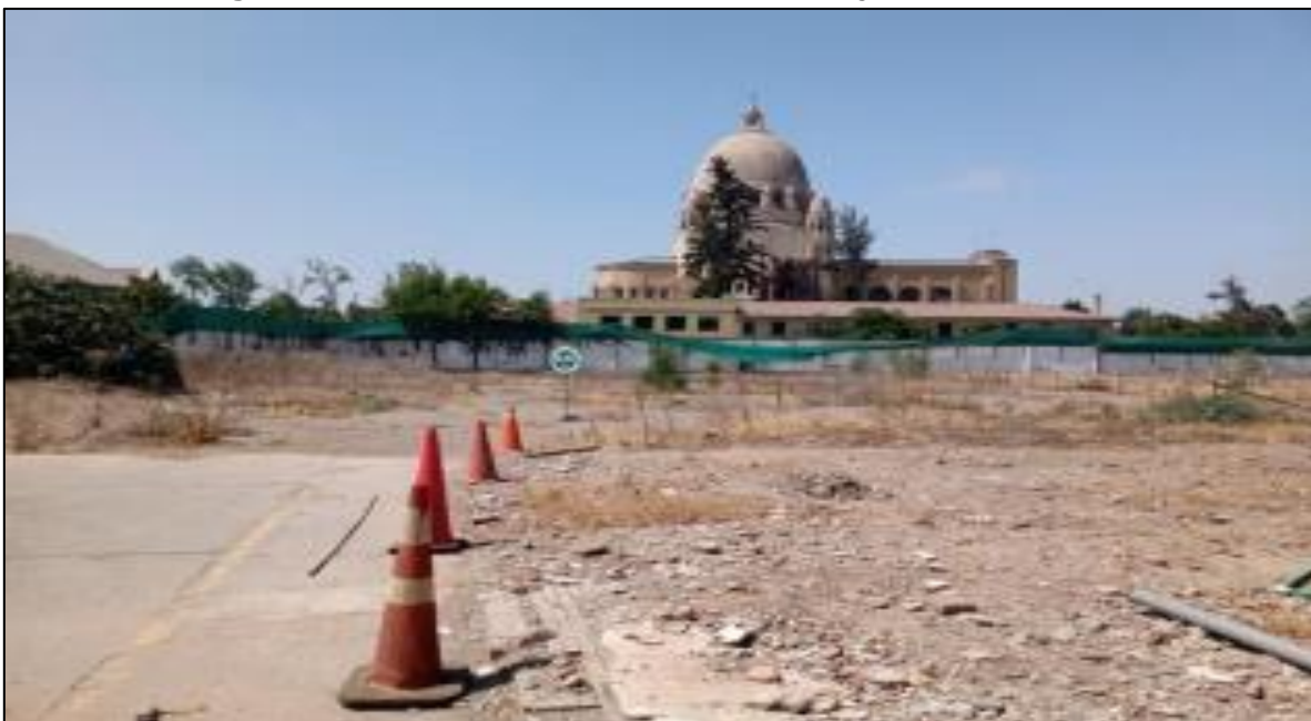
Imagen N° 1: Sitio de emplazamiento del proyecto “San Pablo”.
