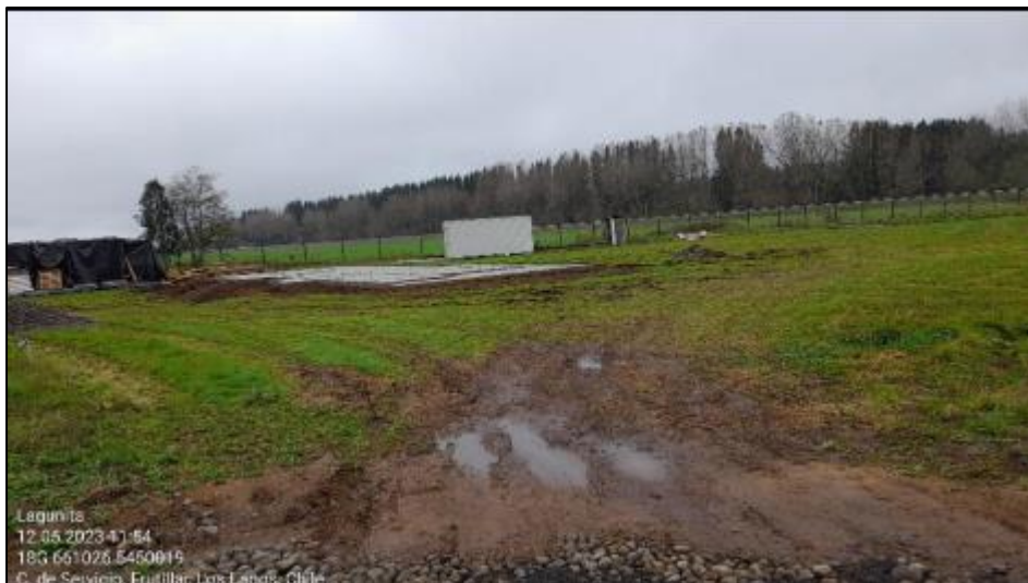
Imagen N° 1: Casa en construcción Proyecto
