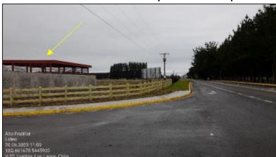
Imagen N° 8: Sala de residuos ubicada en portal de acceso por ruta Teguada
