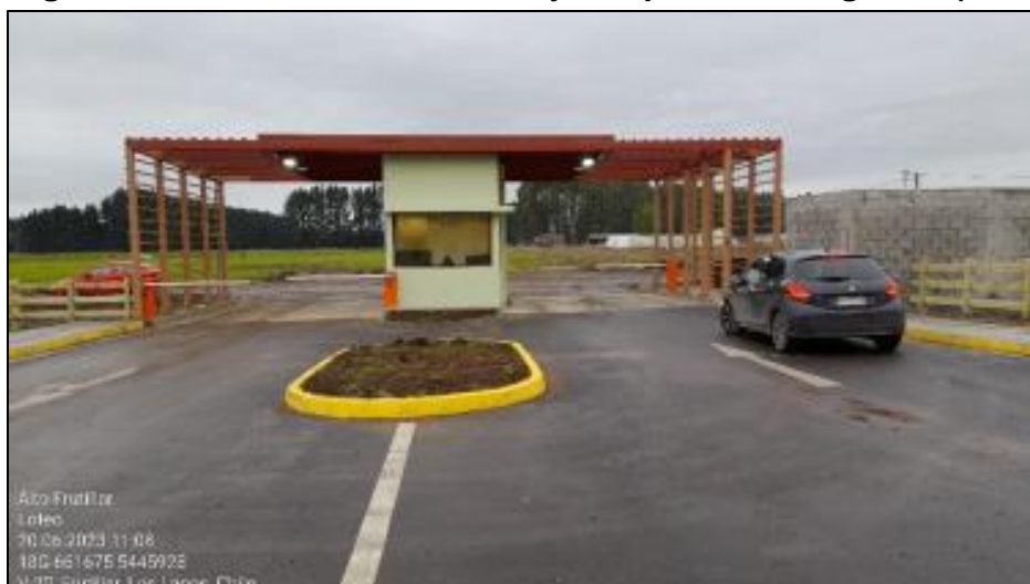
Imagen N° 7: Portal de acceso al Proyecto por ruta a Tegalda (V-200)
