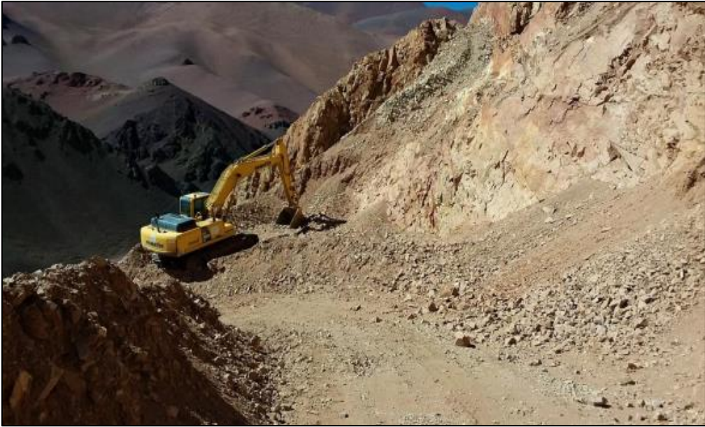
Imagen N° 7: Obras ejecutadas por máquina retroexcavadora.
