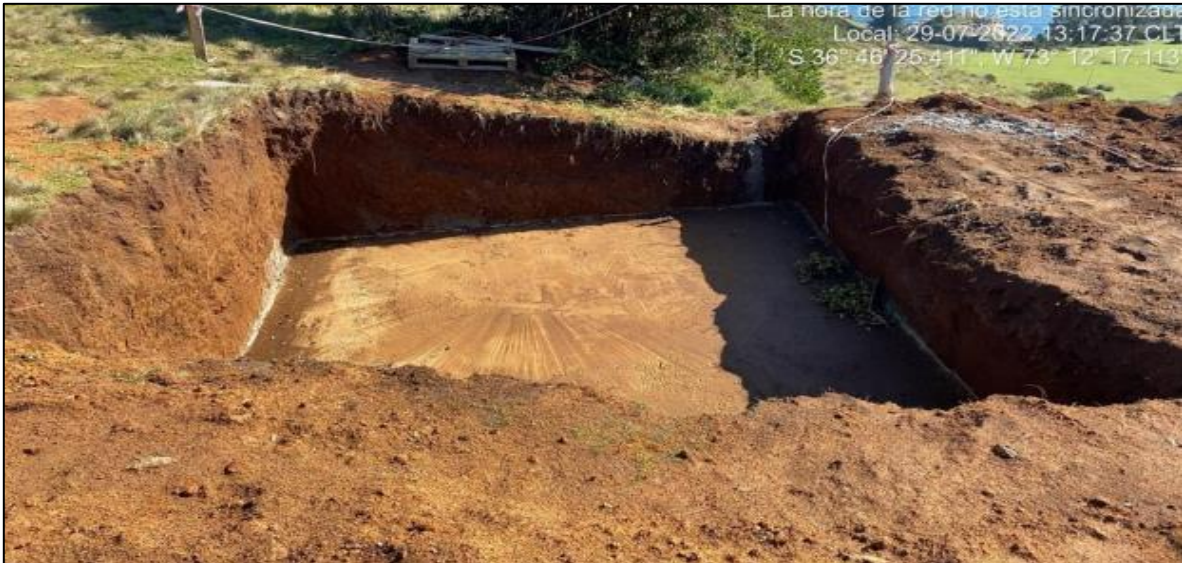
Imagen N° 4: Excavación para instalación de antena.
