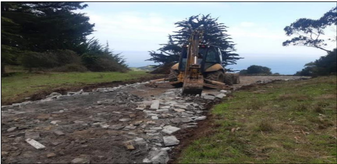
Imagen N° 10: Colocación de primera capa de material de relleno en huella de acceso.
