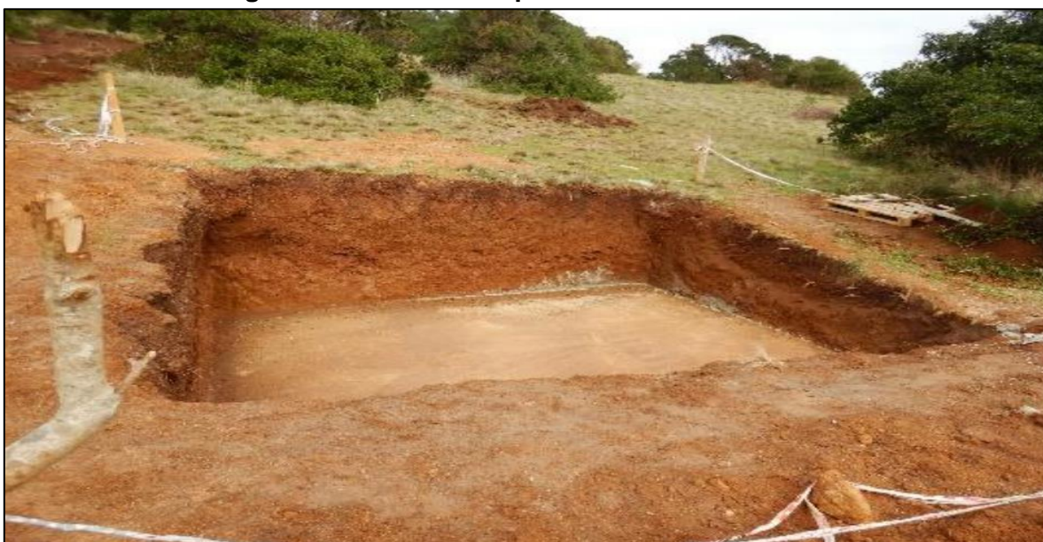
Imagen N° 8: Excavación para instalación de antena.
