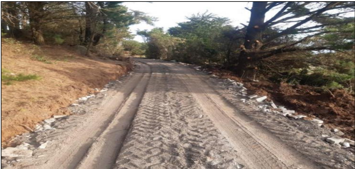
Imagen N° 11: Segunda capa de material de polvo en huella de acceso.
