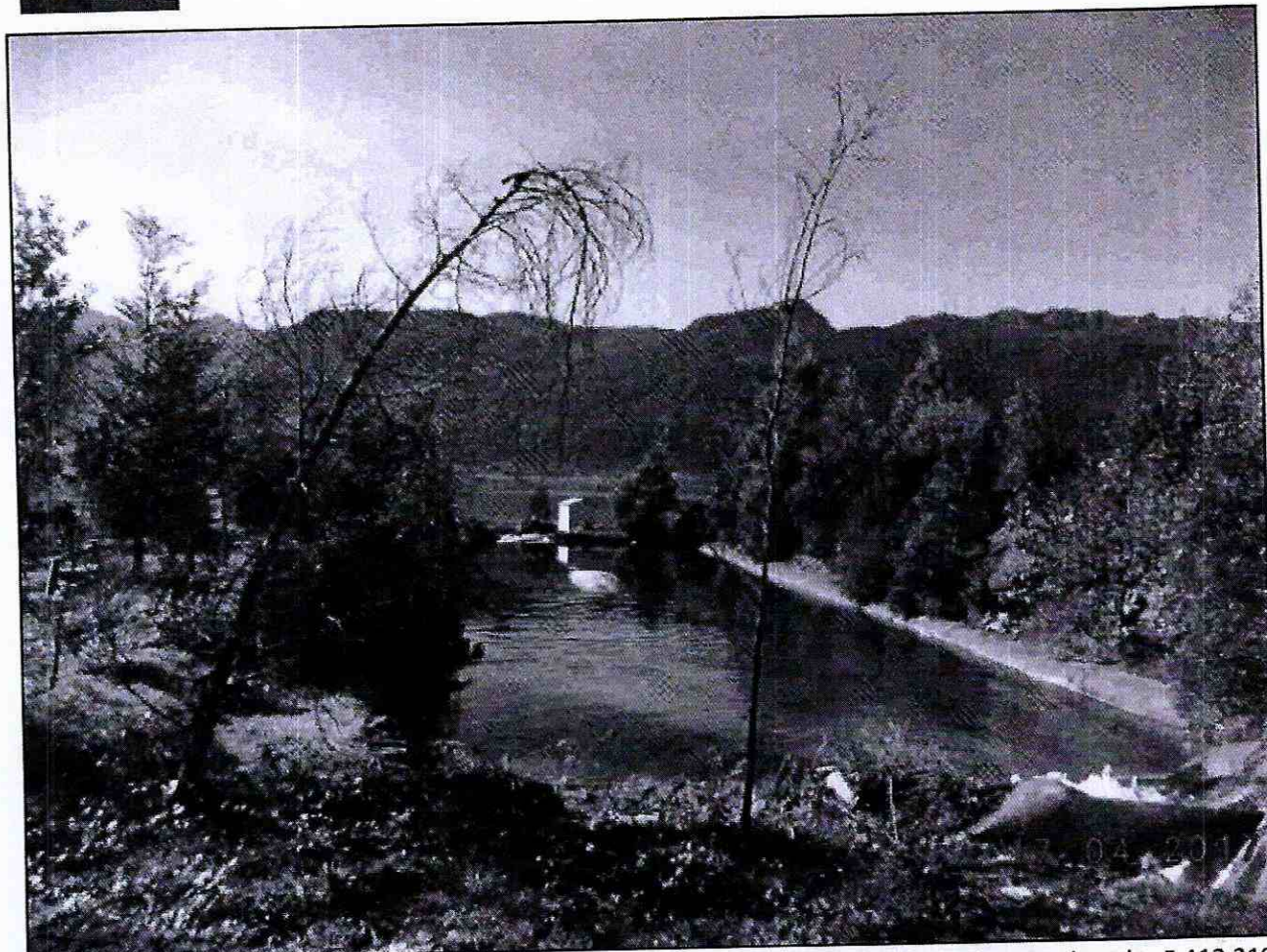
Fotografía N° 3: Vista general de la piscina de decantación de RILes en operación, en las coordenadas 5.413.310 Norte y 723.161 Este
