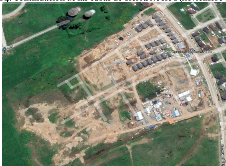
Imagen 4: Continuación de las obras de Tierra Noble I (noviembre de 2017)
