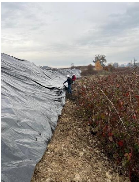
Figura 10: Recubrimiento de material terrígeno con cubierta de polietileno
