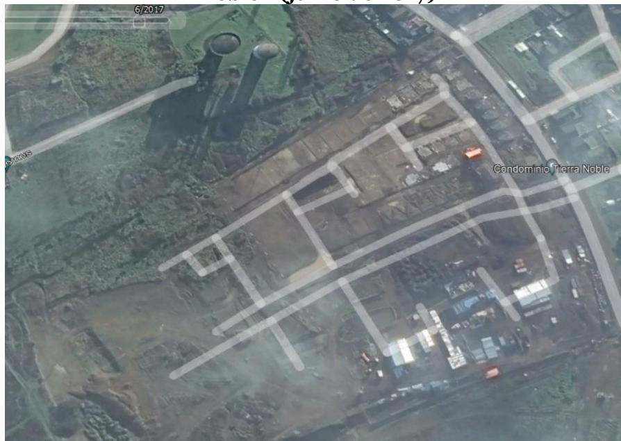
Imagen 3: Inicio de ejecución de las obras e instalaciones de faena de Tierra Noble I (junio de 2017)
