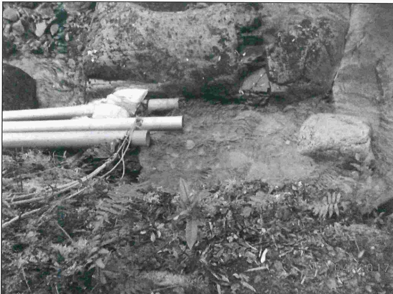
Fotografía N° 9: Se observa captación de aguas adicionales, en mismo estero, en sector ubicado aguas arriba de la bocatoma en las coordenadas 5.413.116 Norte y 722.698 Este
