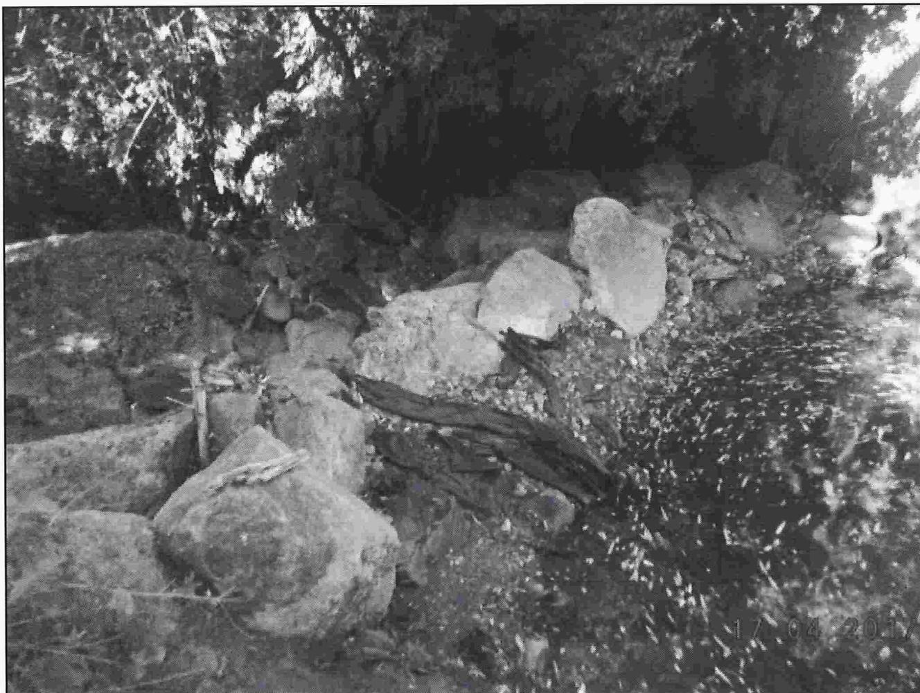
Fotografía N° 8: Se observa muro de captación de aguas construido con material terrígeno y pedregoso que actúa como bocatoma, emplazado en las coordenadas 5.413.078 Norte y 722.763 Este
