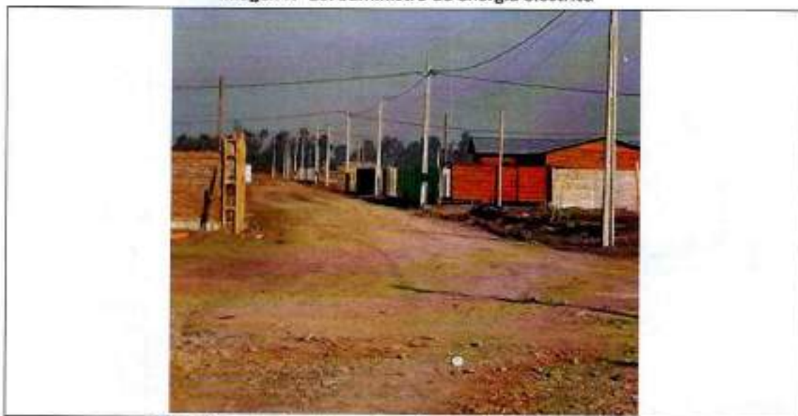
Imagen N° 10. Suministro de energía eléctrica
