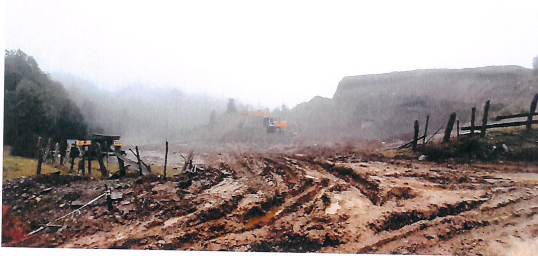
Figura 12. Fotografía extracción de áridos sector bonifacio.
