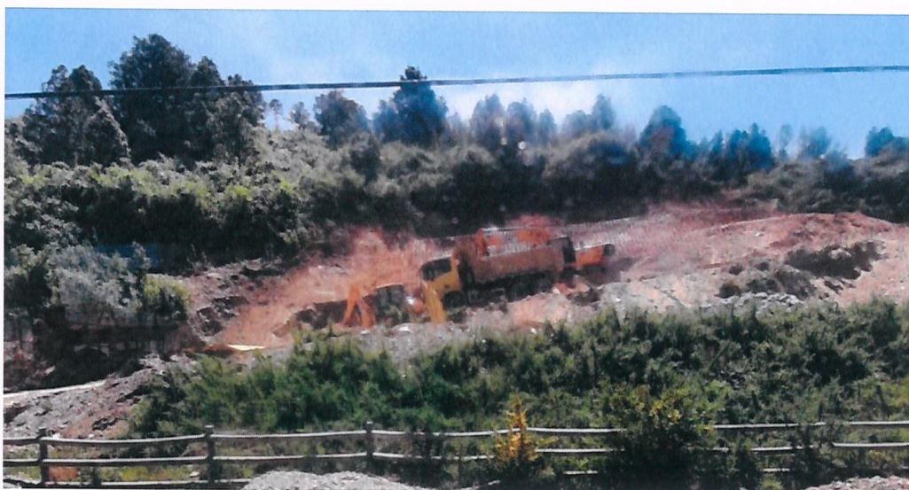
Figura 10: camión y retroexcavadoras trabajando en el loteo Cumbres Valdivianas. 17 de noviembre del 2020
