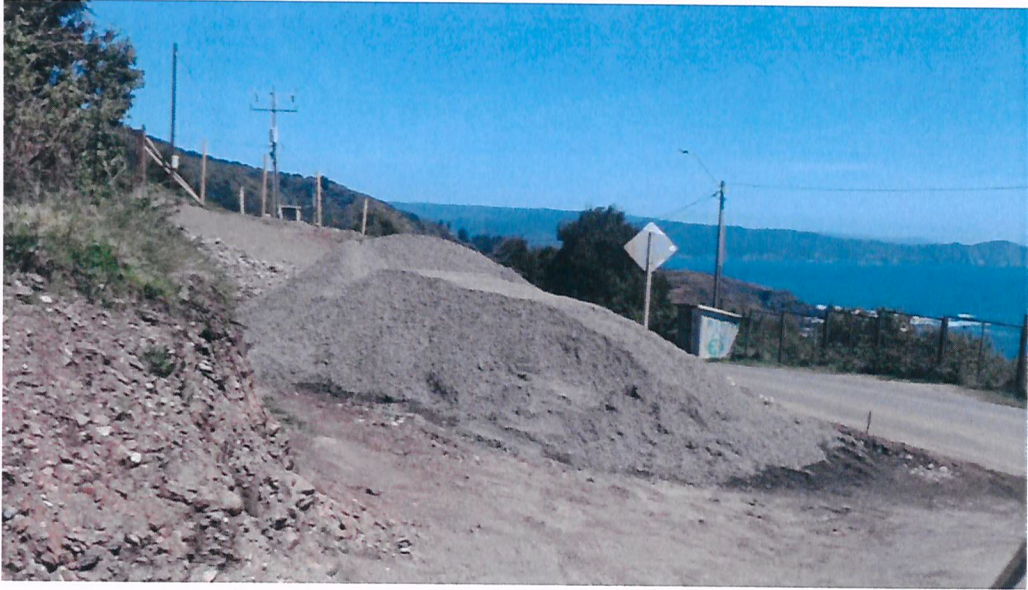
Fotografía 8: material acopiado en el punto de coordenadas -39.812078, -73.397172, ruta de acceso al proyecto “Parque La Ballena”
