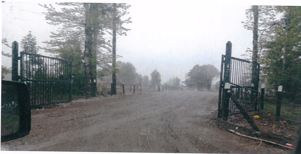
Fotografía 4: Portón nuevo en entrada principal proyecto “Cutipay II”, 12 de noviembre 2020
