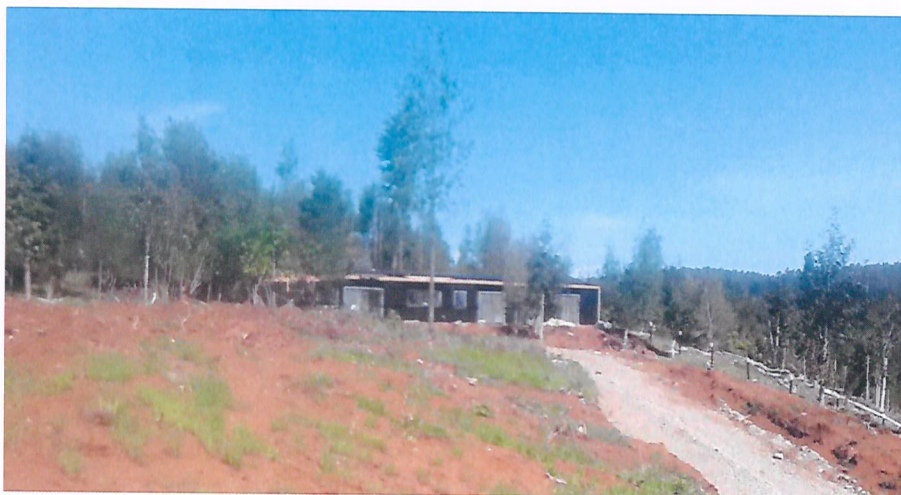
Fotografía 5 – Casa en avanzado estado de construcción proyecto Cutipay II 2 noviembre 2020
