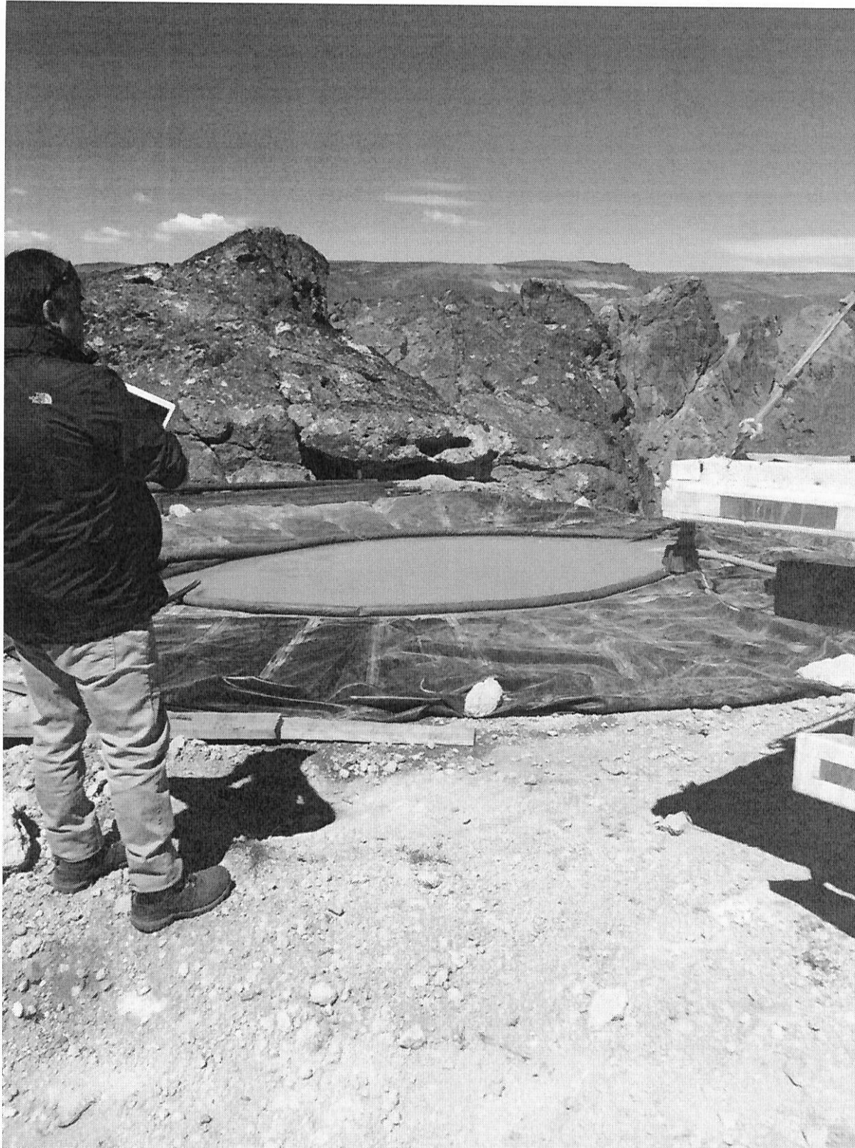
trabajos en camino de penetracion.jpg
