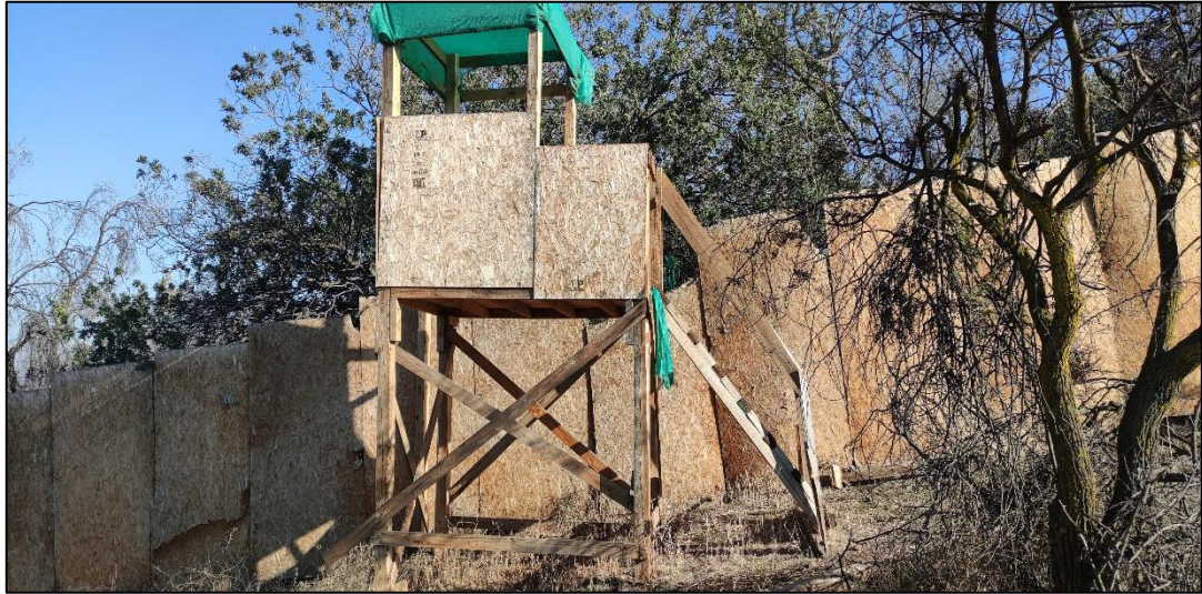
Imagen N° 4: Miradores de vigilancia del proyecto “54 casas”
