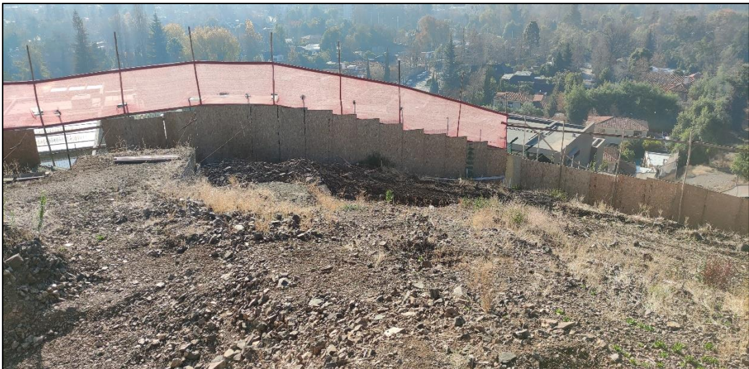
Imagen N° 1: Cierre perimetral del proyecto “54 casas”.
