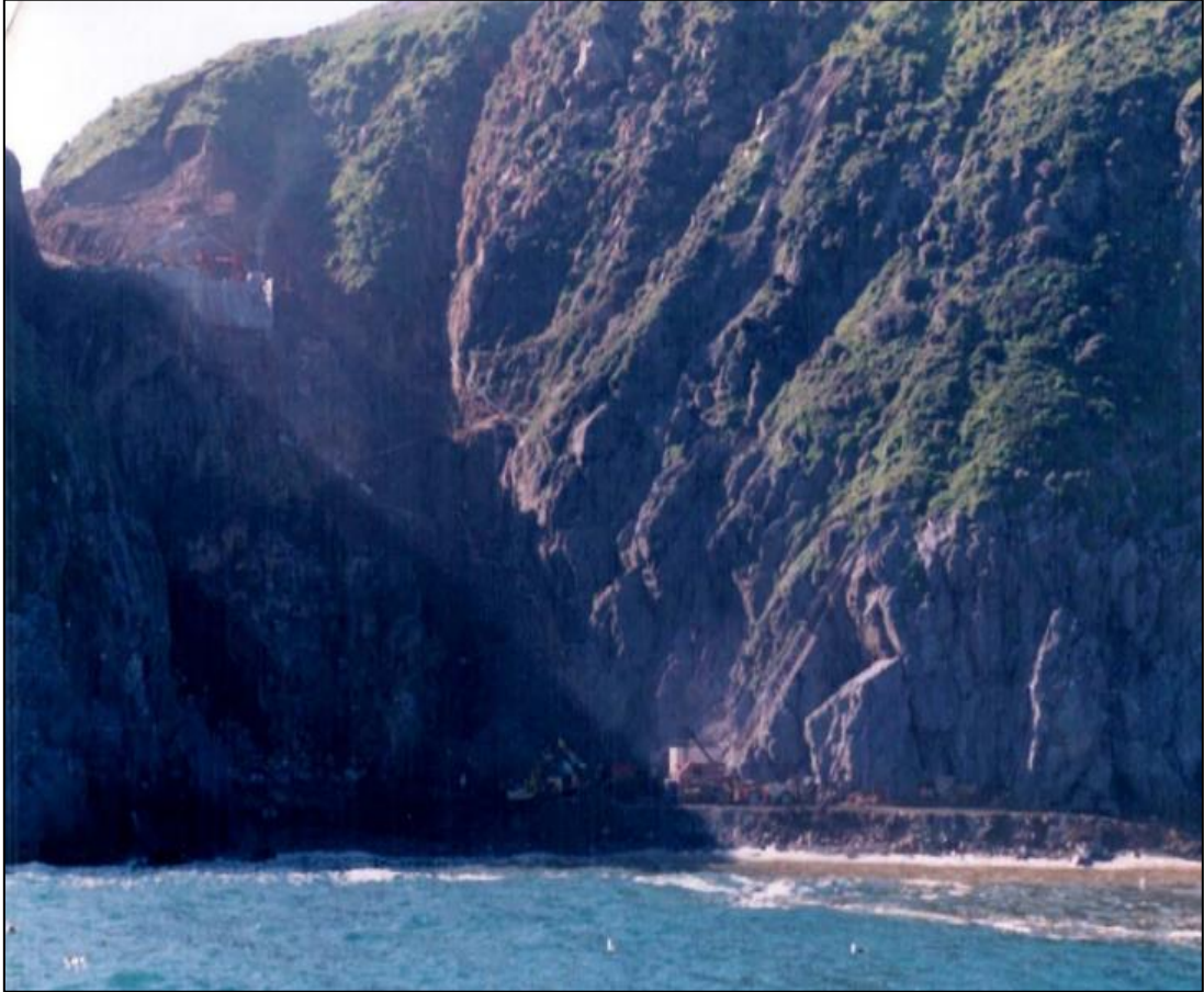
Imagen N° 2: Faenas constructivas del Proyecto.
