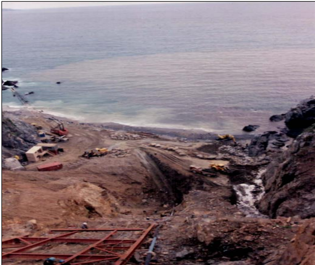
Imagen N° 1: Faenas constructivas del Proyecto.
