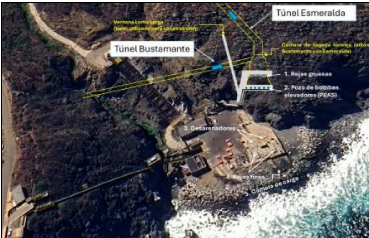
Figura N° 1: Obras del proyecto “Planta de tratamiento de aguas servidas Loma Larga”
