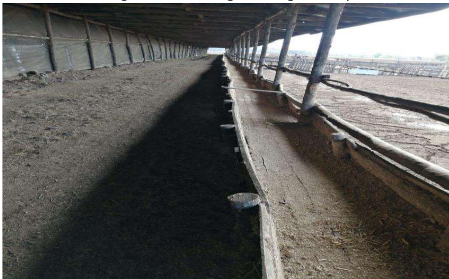
Imagen N° 15: Fotografía engorda “d)” .
