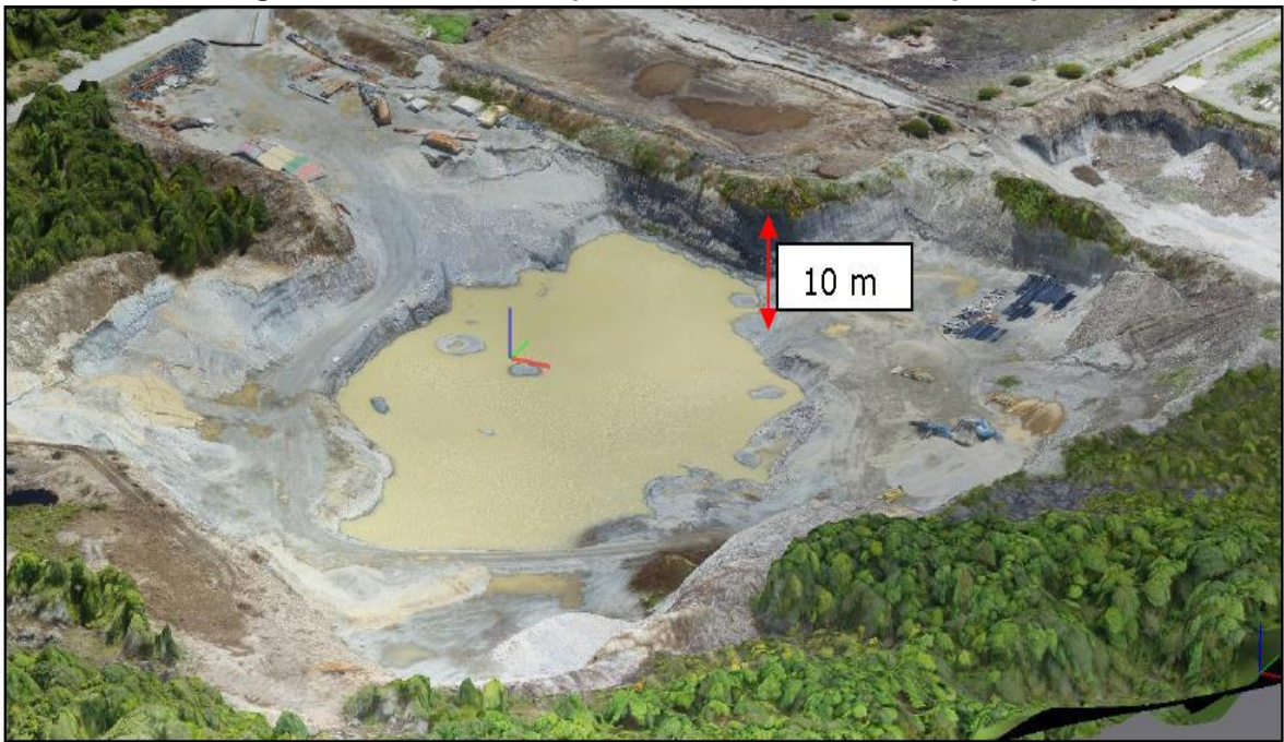
Figura N°6: Profundidad promedio de la excavación principal
