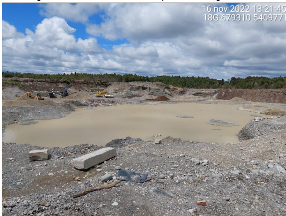
Figura N°2: Área de Extracción con presencia de aguas lluvias
