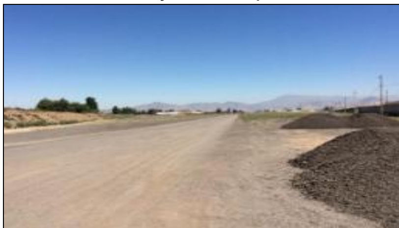
Imagen N° 9: Camino estabilizado y material acopiado en lote sector sur-poniente
