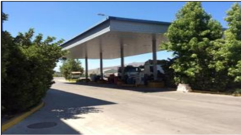
Imagen N° 12: Estacion de combustibles N° 1, cercana al acceso del recinto
