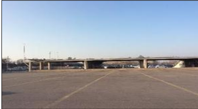
Imagen N° 5: Rampa de carga de vehículos
