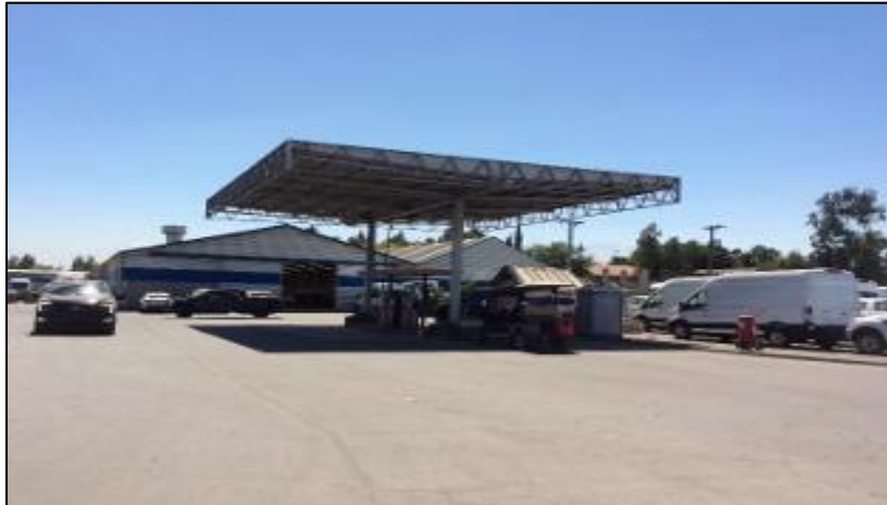
Imagen N° 11: Nueva estación de carga de combustible N° 2
