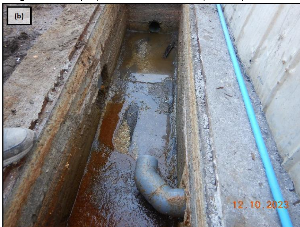
Imagen N°17 letra b): Implementación de cámara N°2 por donde pasa el efluente
