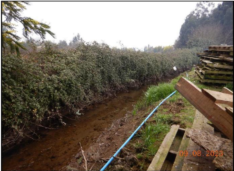
Imagen N°6: Canal de regadío aguas arriba de la descarga.
