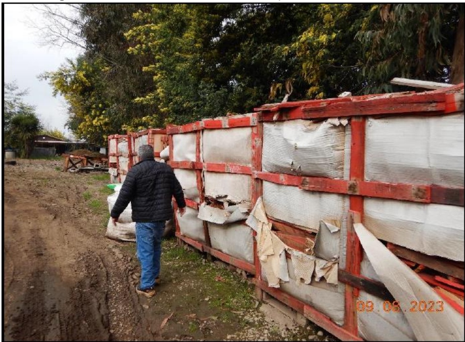
Imagen N°7: Estructura destinada al acopio de trozos de maderas.
