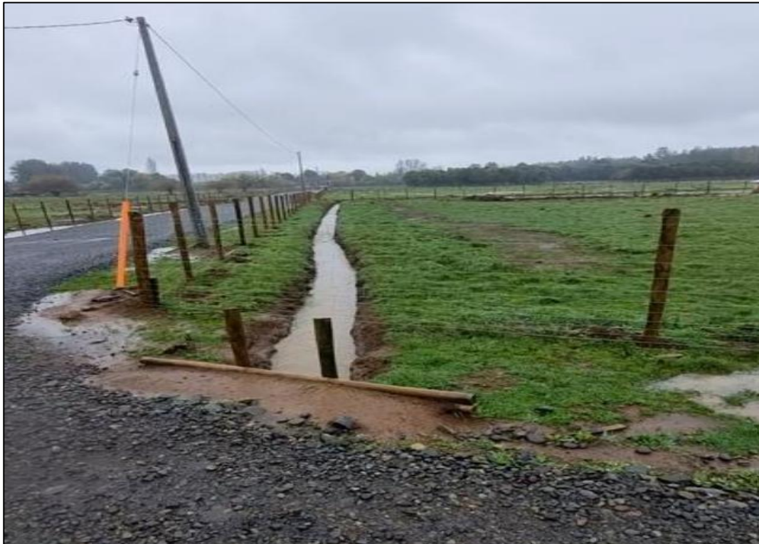
Imagen N° 4: Cercado de lotes al interior del predio, postación y tendido eléctrico, atravesamiento de canales de la red de drenaje y caminos interiores.
