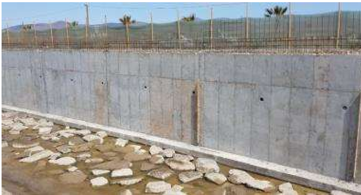
Imagen N° 2: Barbacanas en toda la extensión de los muros.
