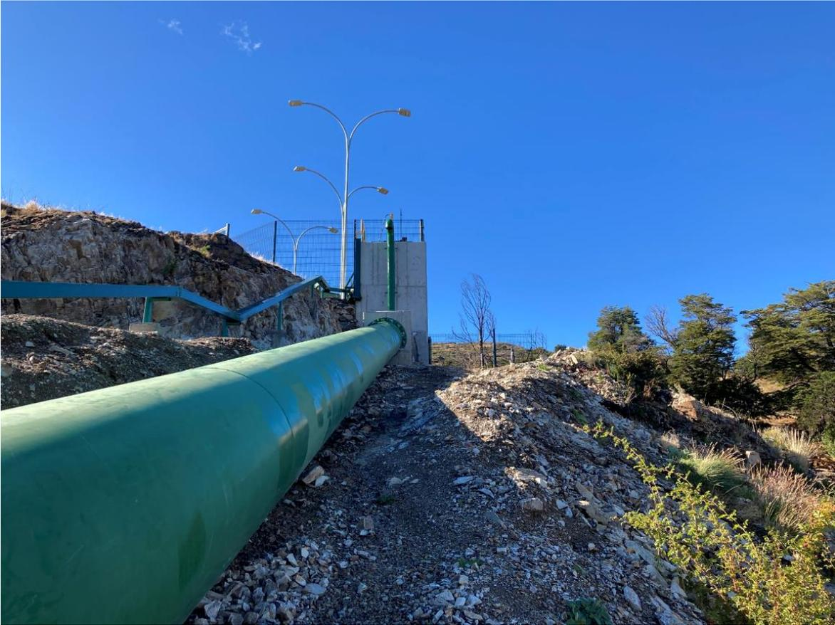
Imagen 8. Conexión de nueva cámara de carga a tubería de baja presión
