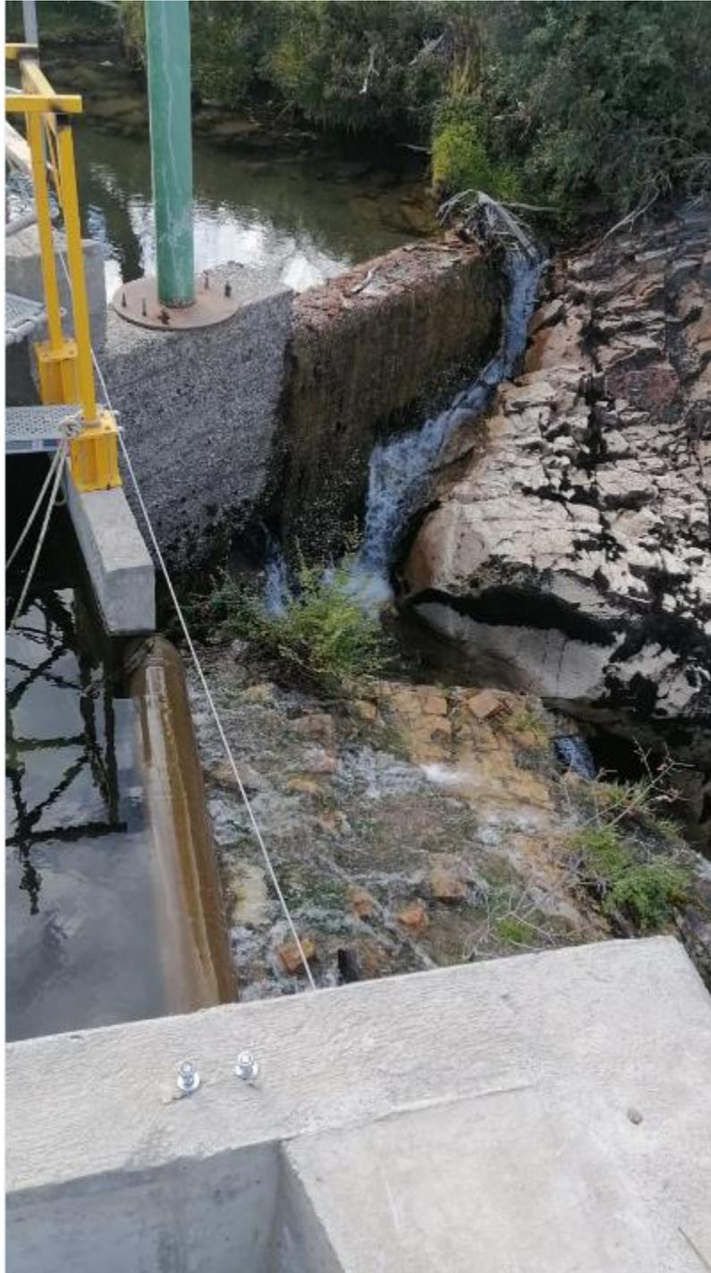
Imagen 16: Muro de Bocatoma 2022 y vertedero
