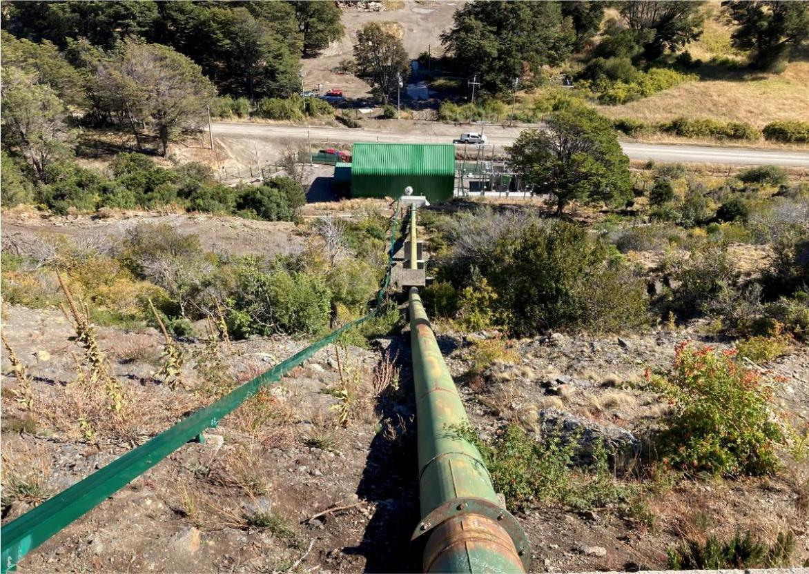
Imagen 4. Tubería de alta presión (antigua) llegando a casa de máquinas
