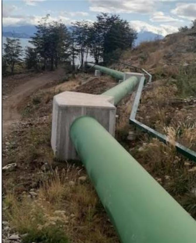
Imagen 14: Tubería de baja presión siguiendo trazado de camino preexistente
