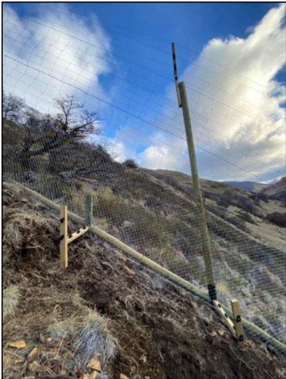
Imagen N°9 y N°10: Sistema de cerco eléctrico inferior y superior.
