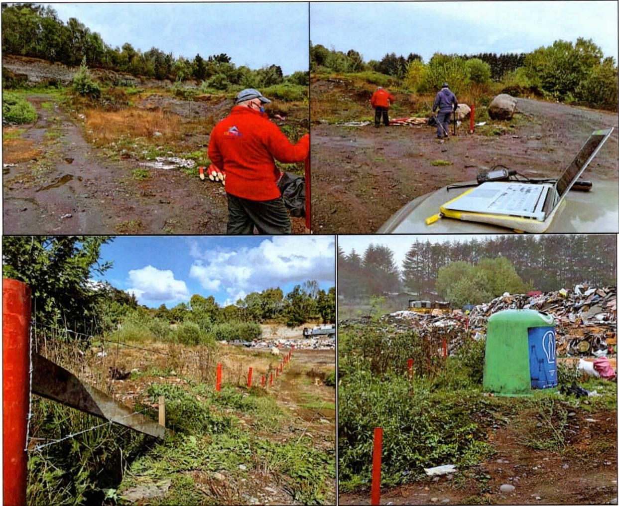
Fig. 5: Delimitación del predio mediante estacas y posterior cierre perimetral (fuente propia).
