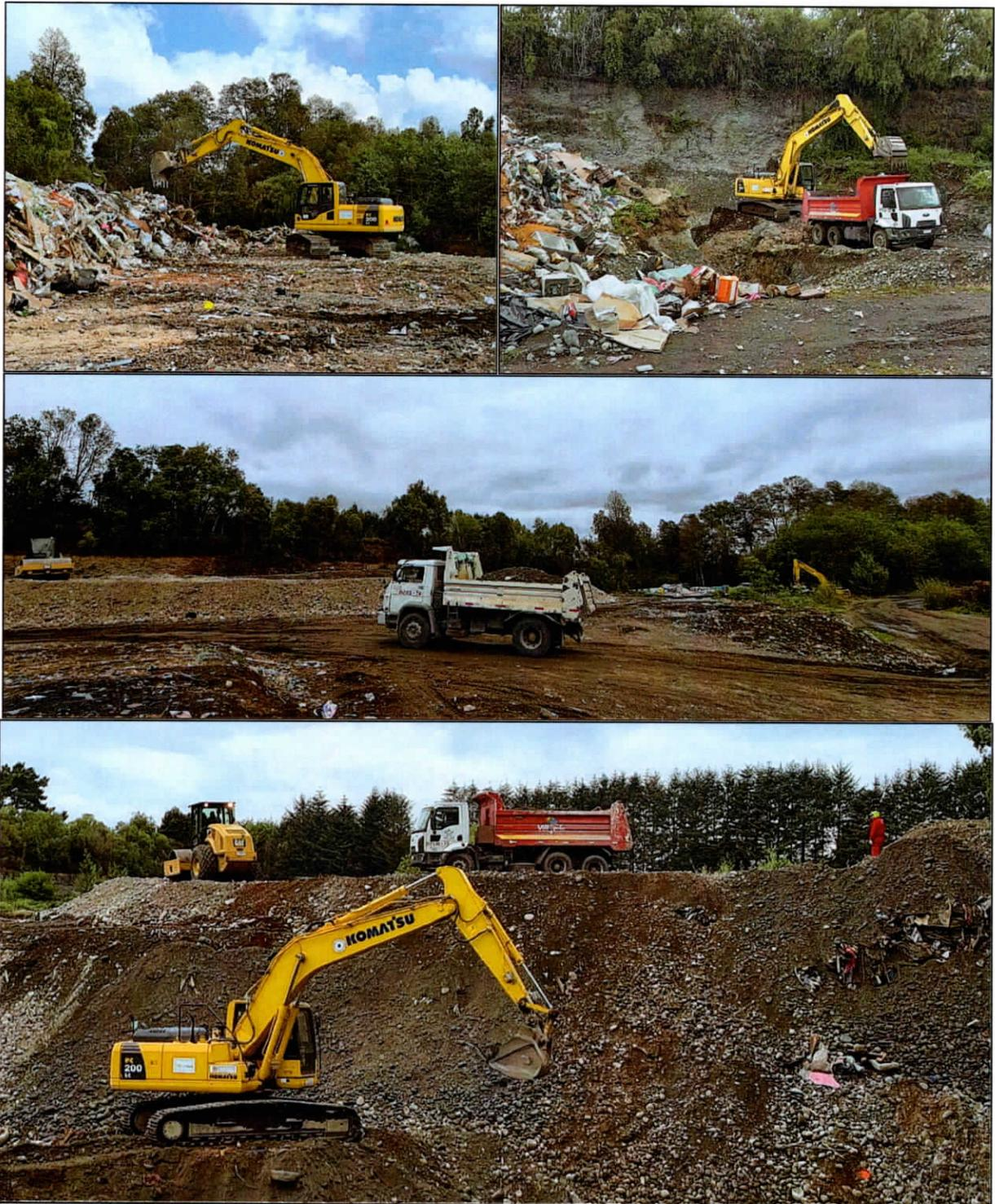
Fig. 6 (cont.): Maquinaria reubicando, compactando y aplicando cobertura los RCD presentes en el predio (fuente propia).
