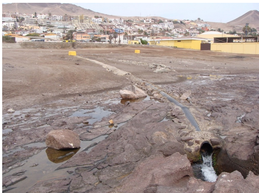
Figura 3. Tubería de descarga efluentes
