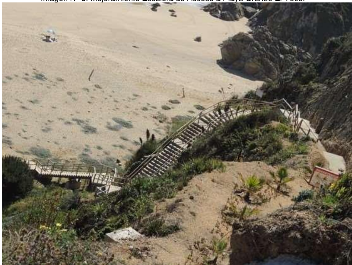
Imagen N° 3: Mejoramiento Escalera de Acceso a Playa Grande El Yeco.
