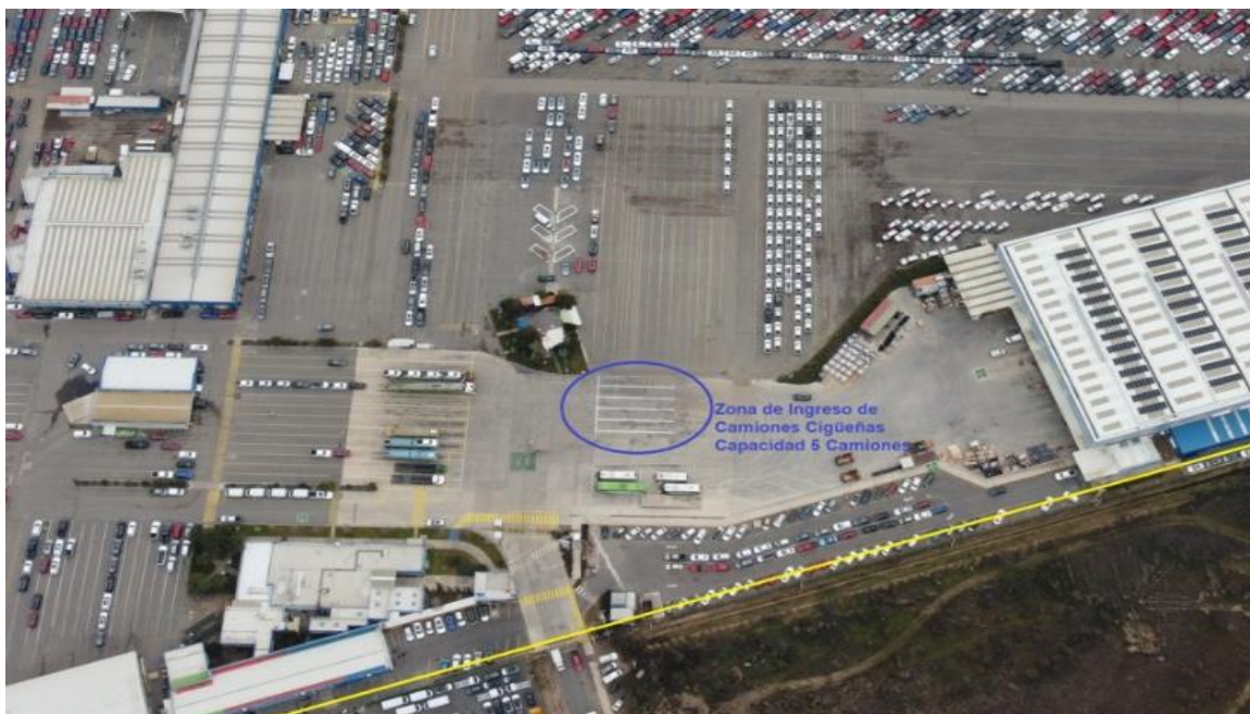
Imagen N° 11: Zona de carga y descarga de camiones cigüeña
