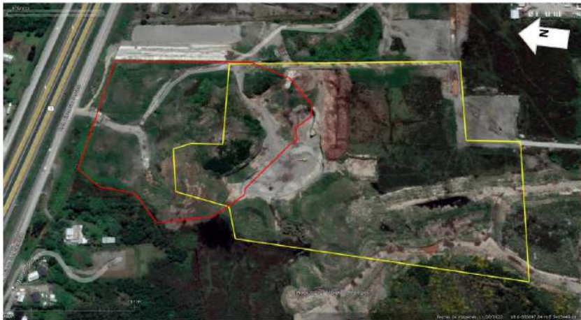
Figura 5. Fecha: ---- Descripción del medio de prueba: Polígono rojo indica al área definida por CRN para faenas de nivelación del terreno (según Figura 4), equivalentes a 4,15 has, y en amarillo el área del humedal, de 8,35 has, observando la sobreposición con el humedal.
