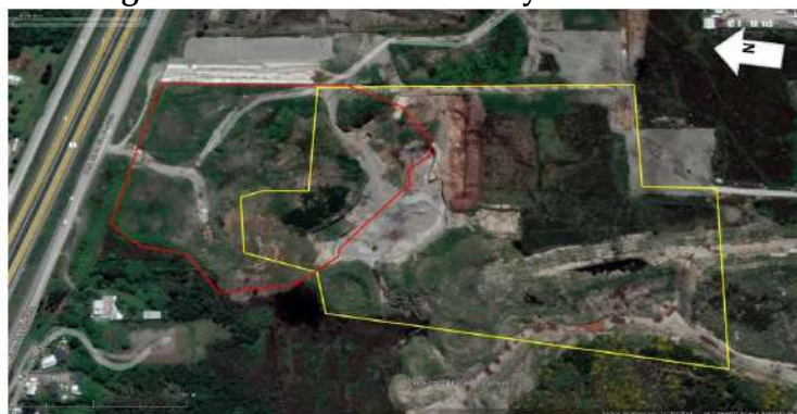
Figura 5. Fecha: ---- Descripción del medio de prueba: Polígono rojo indica al área definida por CRN para faenas de nivelación del terreno (según Figura 4), equivalentes a 4,15 has, y en amarillo el área del humedal, de 8,35 has, observando la sobreposición con el humedal.
