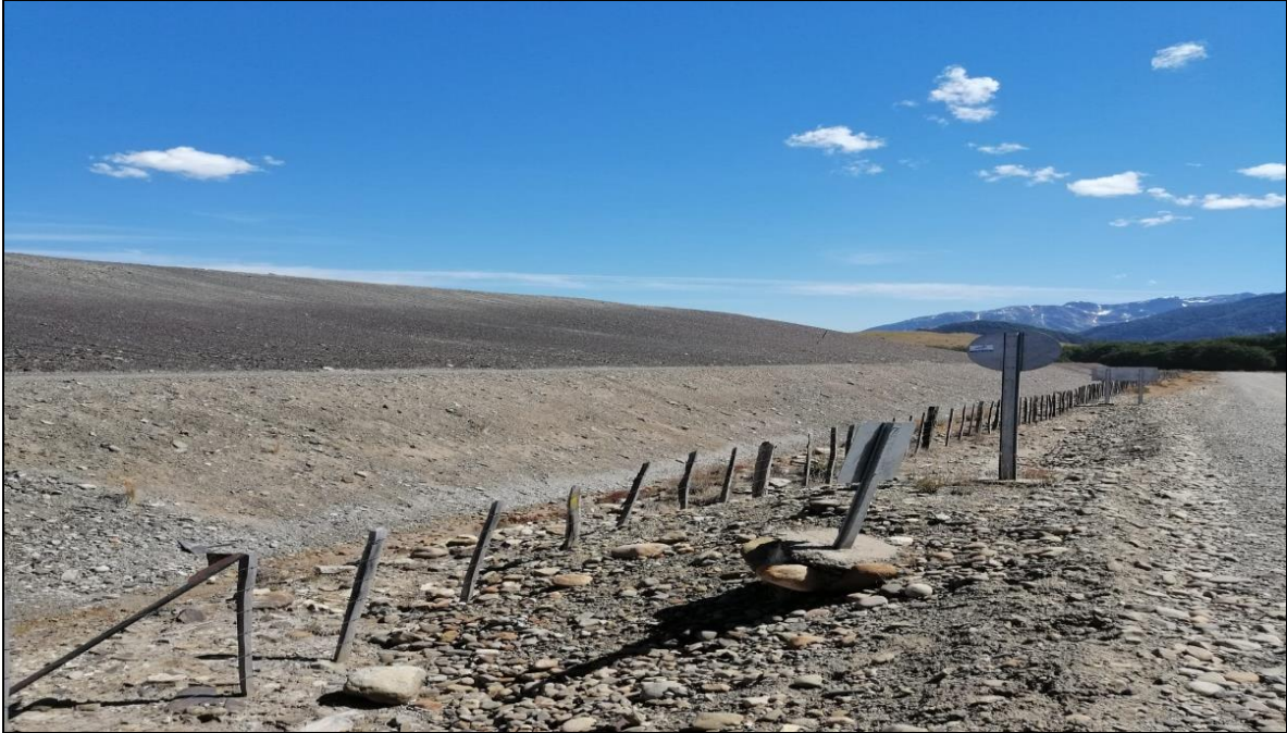
Muro sector lado Este
