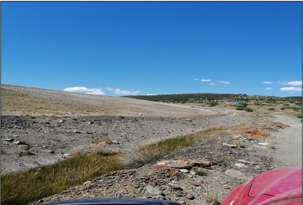
Muro lado Oeste
