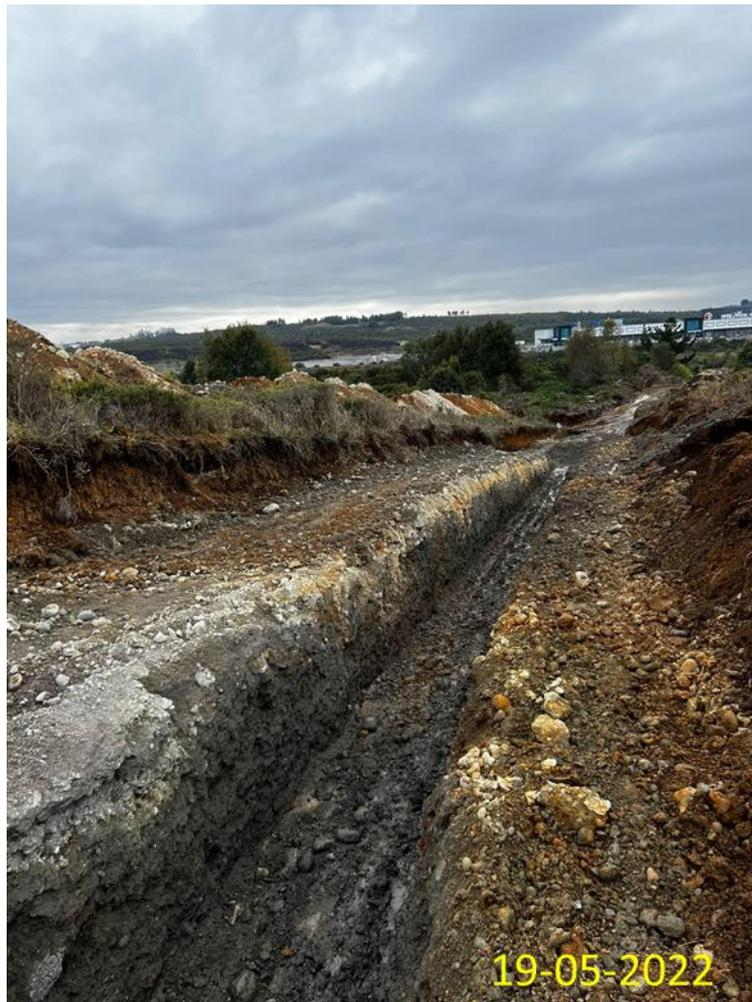
**Registro en Terreno N°5.** Sector de excavación para ubicar colector de Aguas servidas y Cámaras de Inspección aprobados por resolución 67
