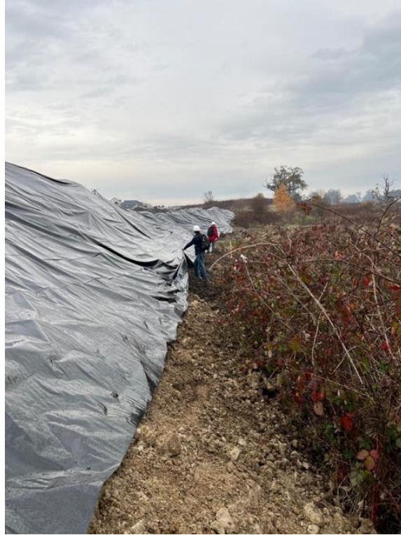
Figura N° 4: Montículo de material aledaño al humedal, cubierto con láminas de polietileno.
