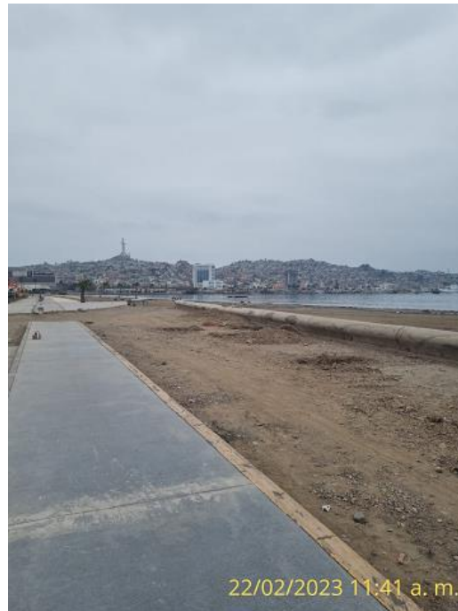
Fotografía 2: Sector falta colocación hormigón en rampa vehicular
