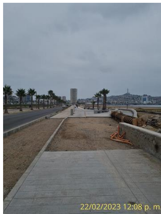
Fotografía 4- : falta pavimento en sector DM 880
