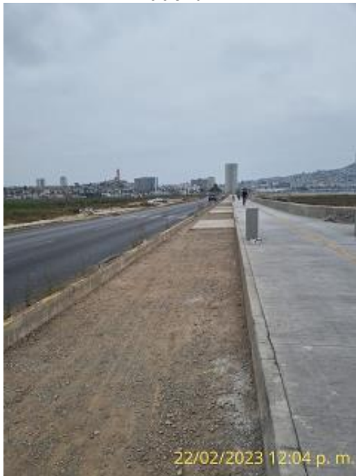
Fotografía 1: Sector falta colocación hormigón en ciclovía
