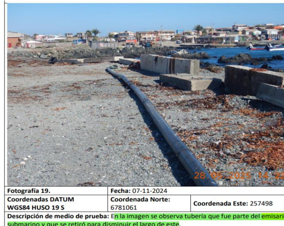
Imagen N°2: tubería del emisario
